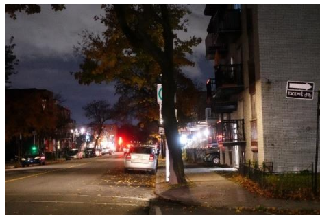
Photo 13 : la signalisation routière est invisible.
