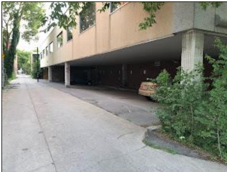
Photo 3 : l'intérieur du parc de stationnement couvert est sombre, même durant le jour.
