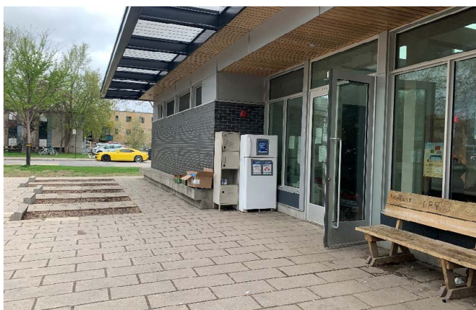
Légende : Le chalet de parc donne accès à différents installations et services, et constitue le seul espace permettant de s'abriter des intempéries dans l'ensemble du parc.
